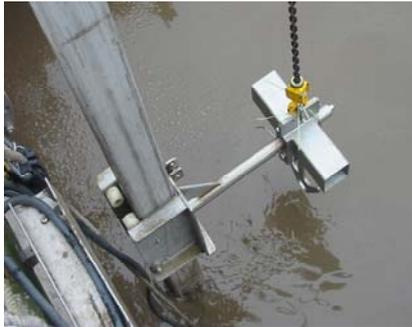
*« Ce dispositif permet de ne pas exposer le câble de potence aux forces mécaniques et subir ainsi une usure prématurée. L'anse de repêchage permet de déposer l'agitateur sur son support. Une fois l'agitateur déposé correctement, l'anse de repêchage automatique se décroche et peut être sortie».*
