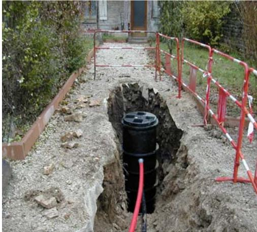
Cette tranchée étroite et peu profonde a reçu la canalisation principale en PEHD de faible diamètre (63 mm).
