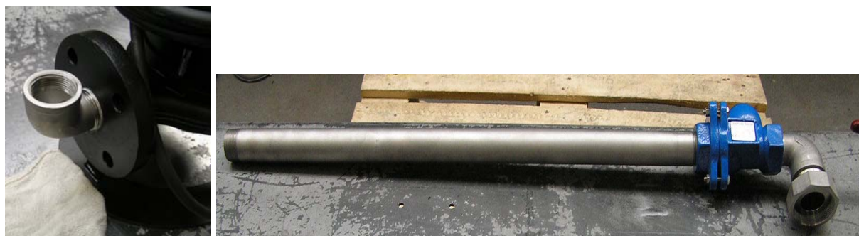
Figure 4 : montage de la canalisation de refoulement
